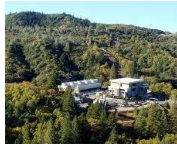
55 MW Geothermal Due Diligence
