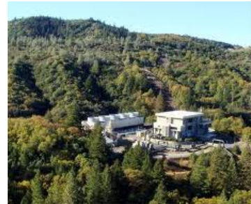
55 MW Geothermal Due Diligence
